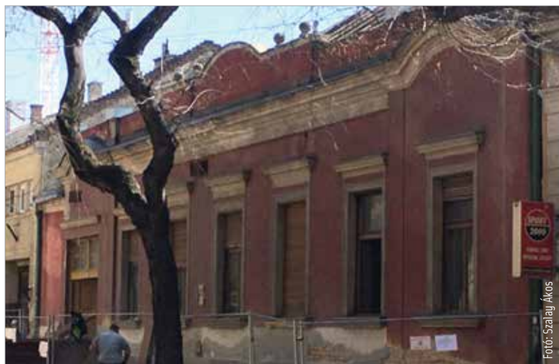
Az Ady Endre utcai épület a bontás előtt
