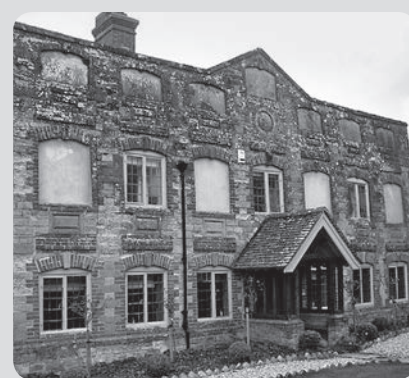
Az ablakadó ra napjainkig emlékeztetnek az angol kastélyok és lakóházak befalazott ablakai (vakablakai)
