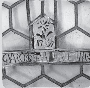
Ablak-ólommal összeillesztett hatszögletű üvegtáblák a háromszéki Magyarós református templomának ablakán
