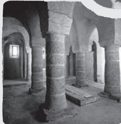
A szentély alá gyakran altemplomot is építettek dísztelen oszlopokkal, boltozatos mennyezettel (a tihanyi apátság altemploma, 1055).
