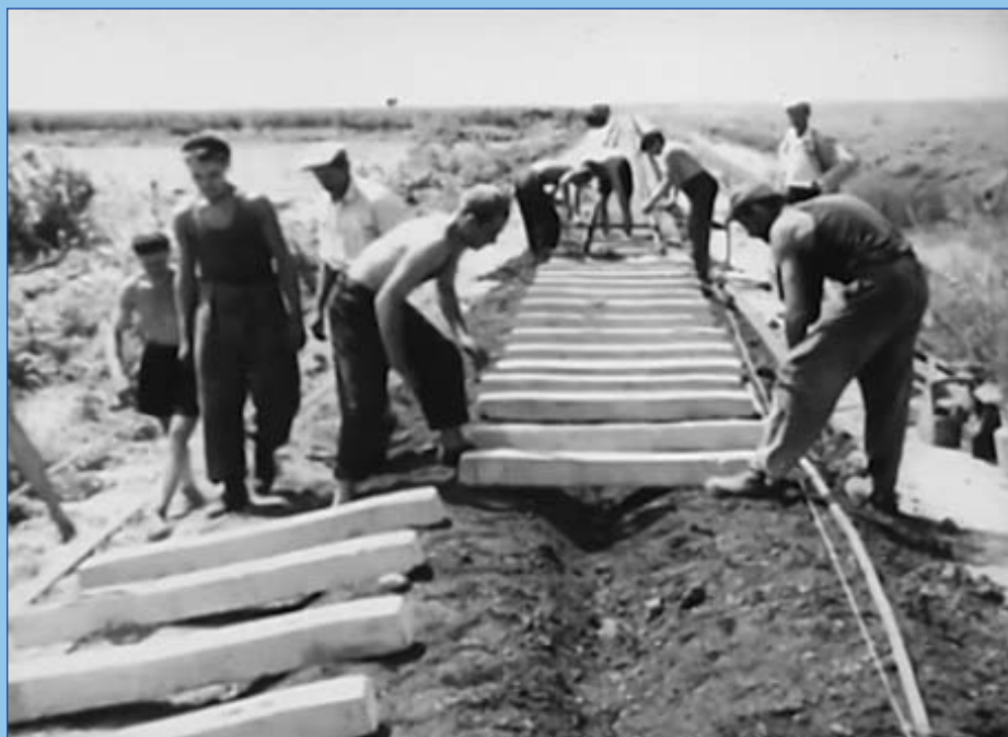
A gazdasági vasút alapját a rabok építették
