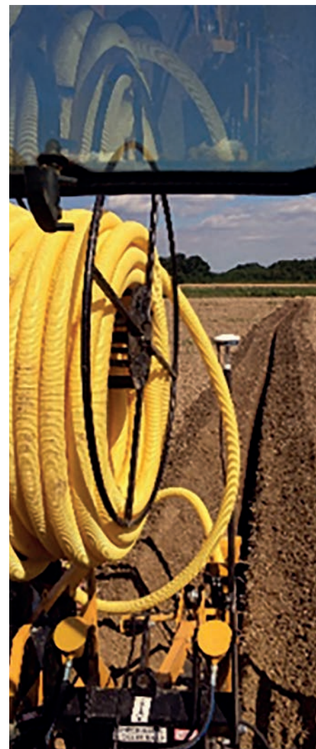
5. kép. Drén csövek lehelyezése
