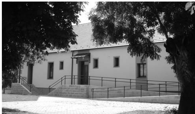
A kúriaépület a felújítás után (A szerző felvétele, 2019)
