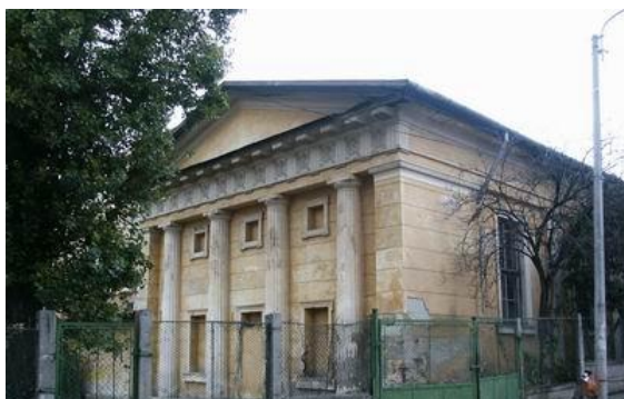
13. A tornaterem kollégium felőli homlokzata
