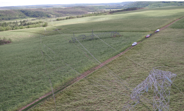
3. ábra. Szupercella által 2017.07.24-én megrongált 400 KV-os vezeték Pécs környékén. (MAVIR drón felvétel)
