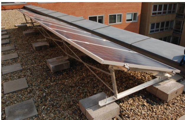
6. ábra: A 3,3 kW p -s rendszer napelemei
