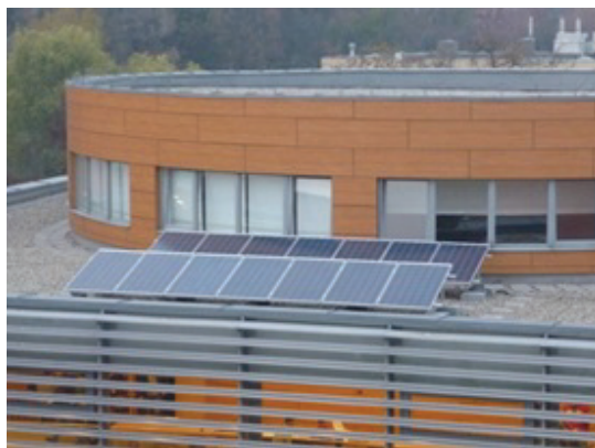
6. ábra: A 3,3 kW p -s rendszer napelemei
