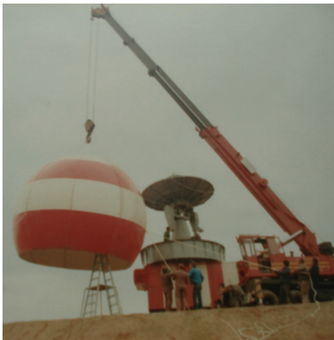
A ferihegyi radar telepítése
