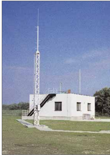
Az állomás épülete
