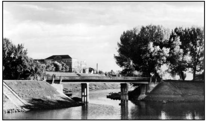
Az elkészült betonhid hosszú ideig egyik meghatározó eleme volt a bajai városképnek
