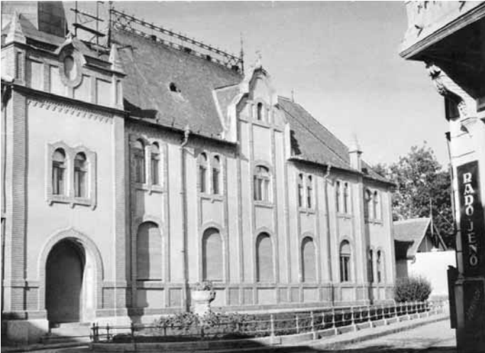
A Takarékpénztár déli frontja az emelet-ráépítés (1925) után
