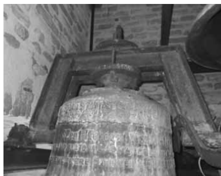
A megtört vonalú, ún. Pozdech-járóm és az alulütős harangozási rendszer a legelterjedtebb Magyarországon
