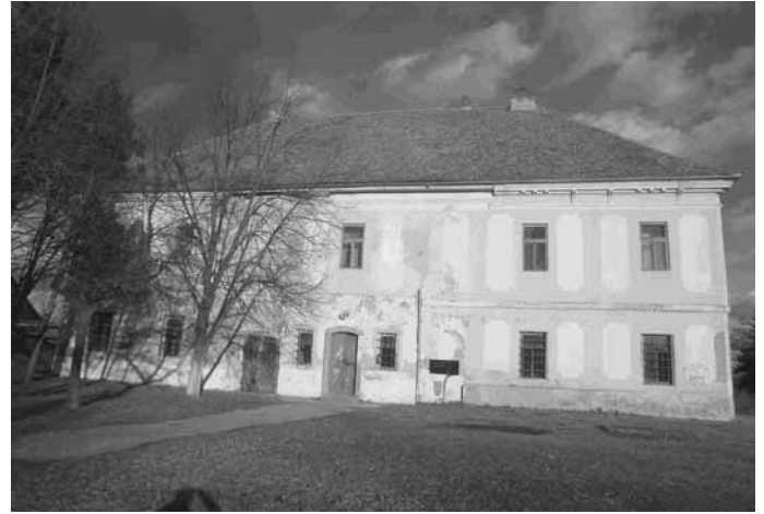
A kastély jelenleg, a karakterét adó kiugró homlokzati részt elbontották. Még megmenthető!
