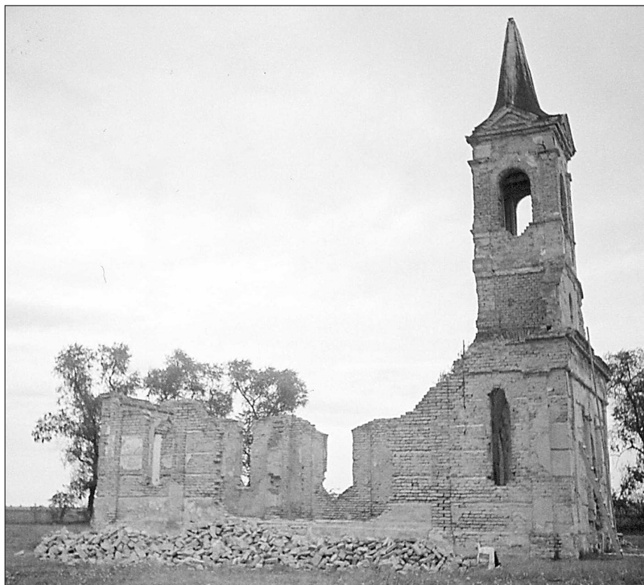
A kápolna a felújítás megkezdése előtt, 2003-ban
