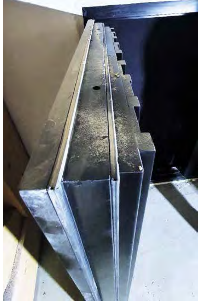
A zenekari árok felé diffúzorfelület-kialakítású ajtó a nyomótér felől (2022. 02. 09.)
