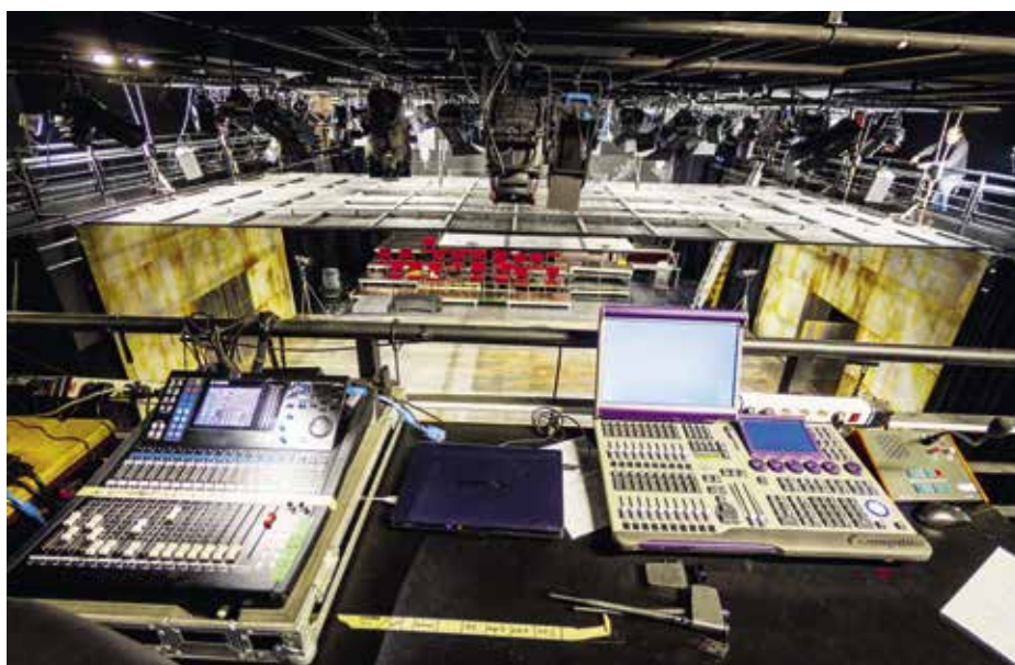
A Márkus Emília Terem fény- és hangvezérlői a munkakarzaton
