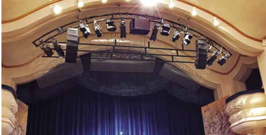
A színpadi bársony előfüggöny és díszes takarórésze. A hangsugárzók a világítási tartóra kerültek
