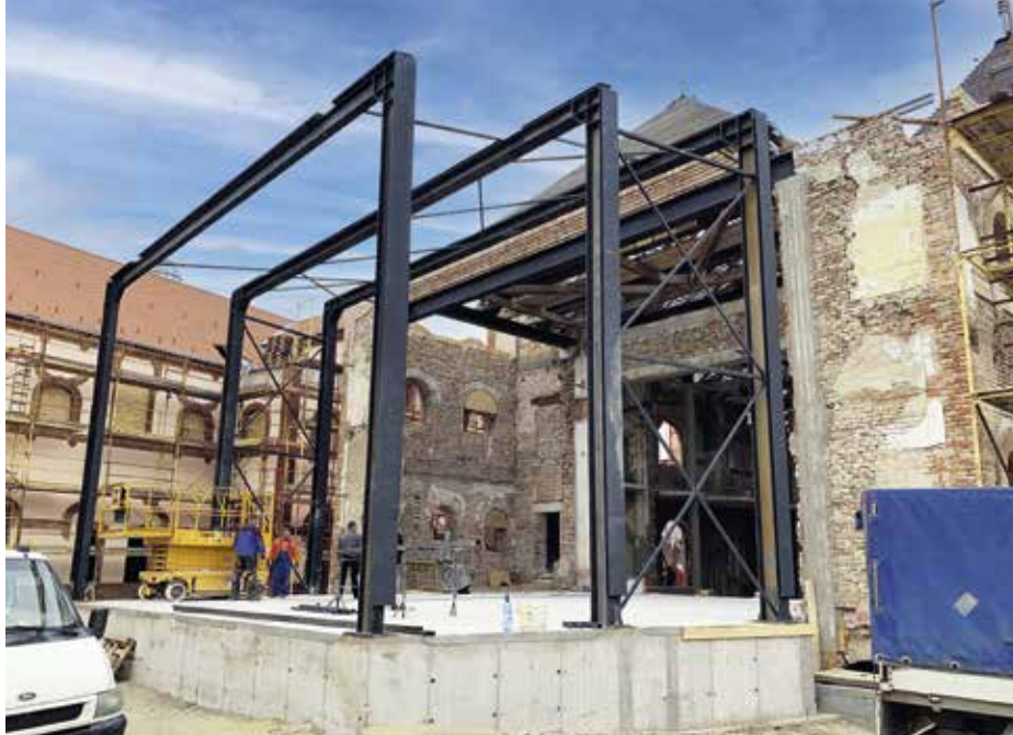
A színpadbővítés acél tartószerkezetének felállítása, 2019. október
