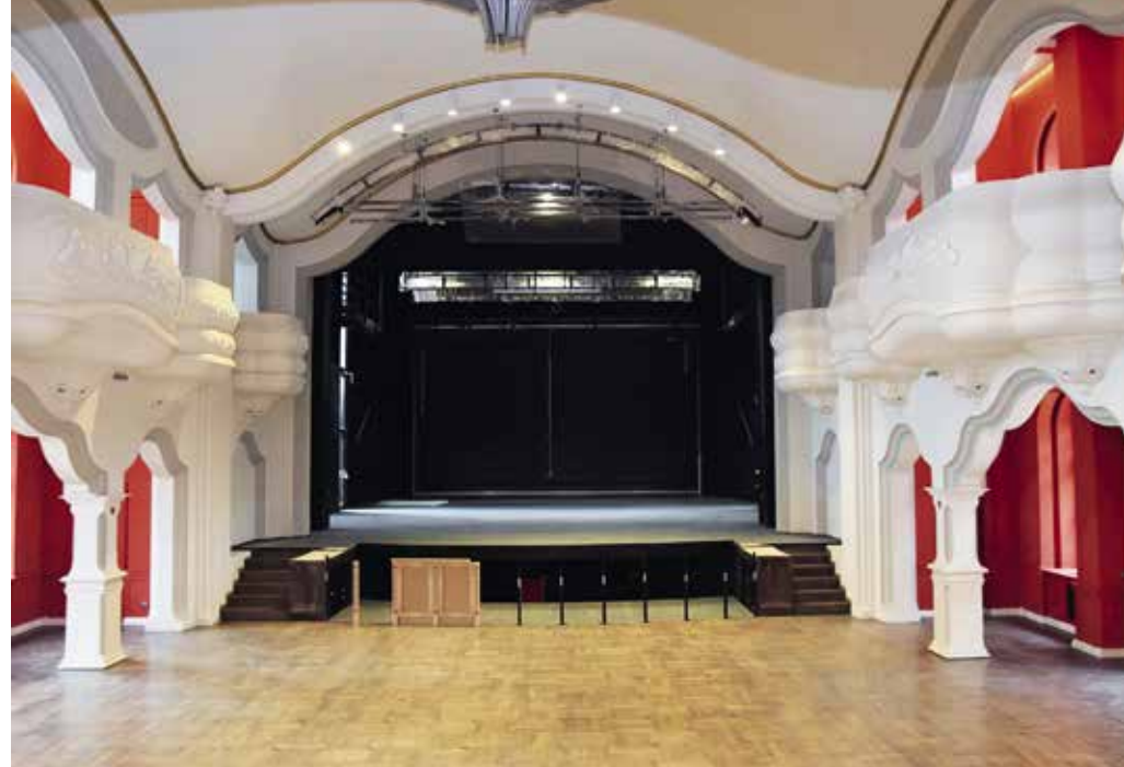
A síkpadlós nézőtérhez csatlakozik a leeresztett zenekari árok-süllyedő, a mellvédjét éppen kiszerelik
