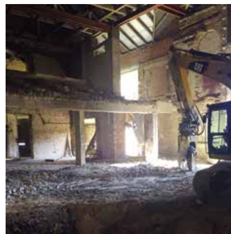
Az 1967–69-es átépítéskor létesített erkély szerkezetének elbontása 2019-ben
