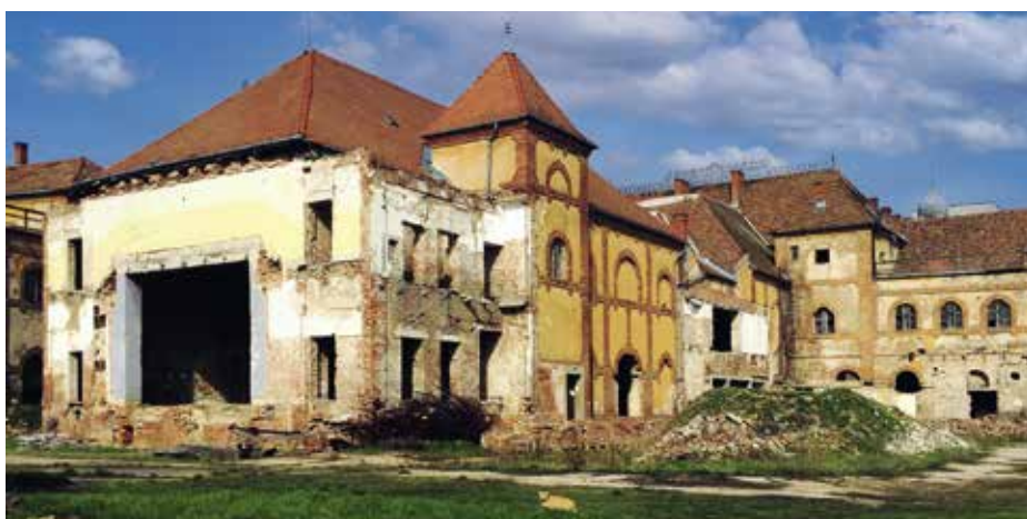
A romos épület, az elbontott színpadból csak a beton színpadnyílás maradt meg
