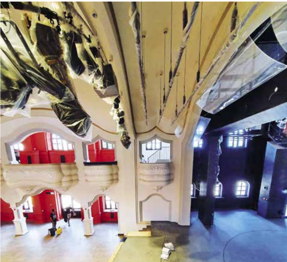
Az előszínpad zóna prosceniumpáhollyal, az első világítási tartóval, előszínpadi díszlethúzókkal
