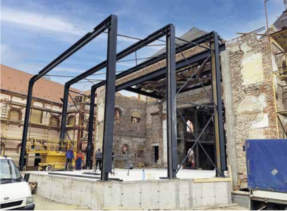
A színpadbővítés acél tartószerkezetének felállítása, 2019. október
