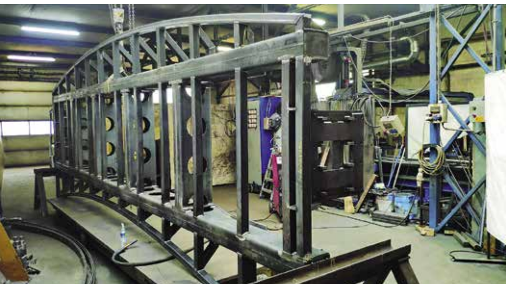
10. ábra: A fedlap szerkezetének gyártása a műhelyben
