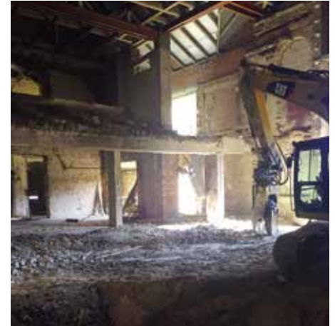
Az 1967–69-es átépítéskor létesített erkély szerkezetének elbontása 2019-ben
