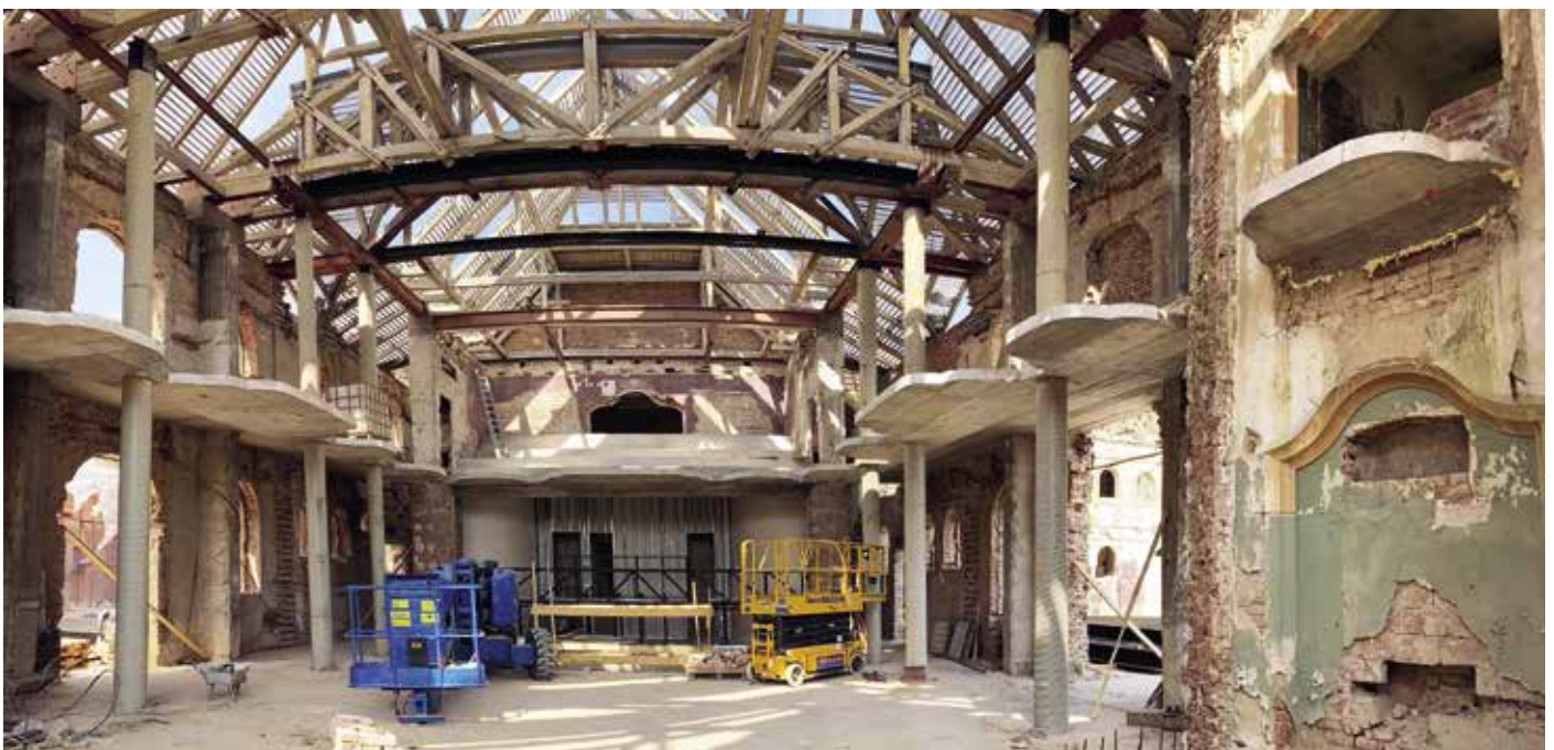
A nézőtér tetőszerkezetének helyreállítása, 2019. augusztus
