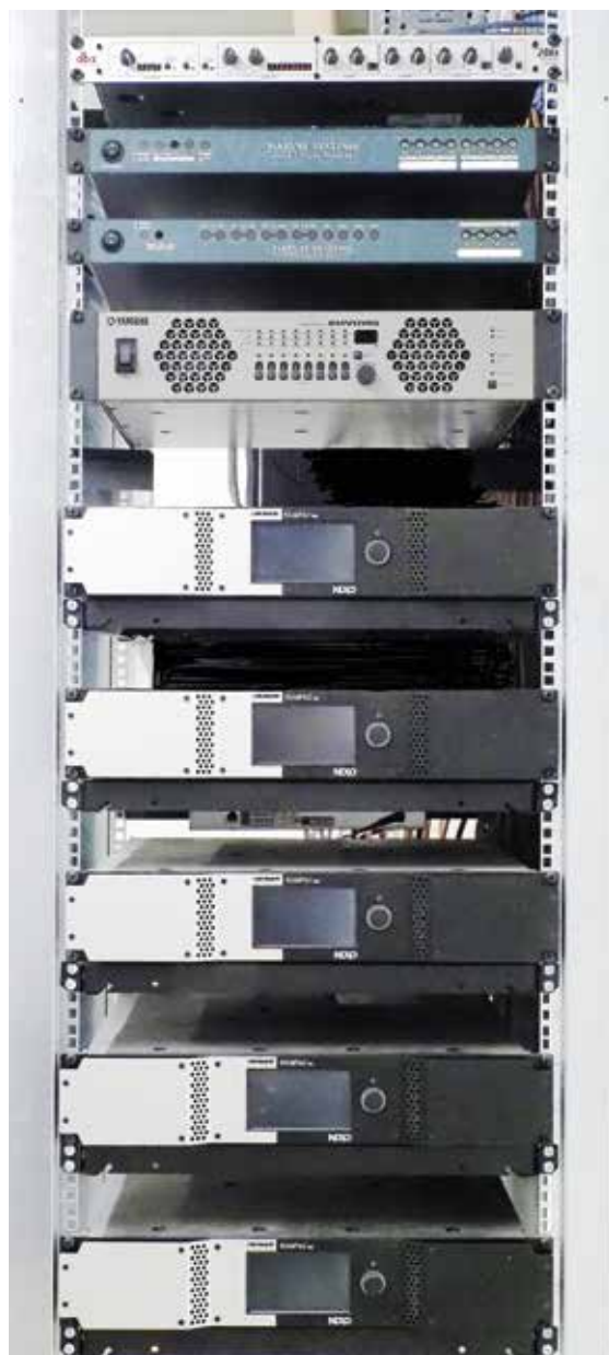
Az ügyelői rendszer központja és a végerősítők
