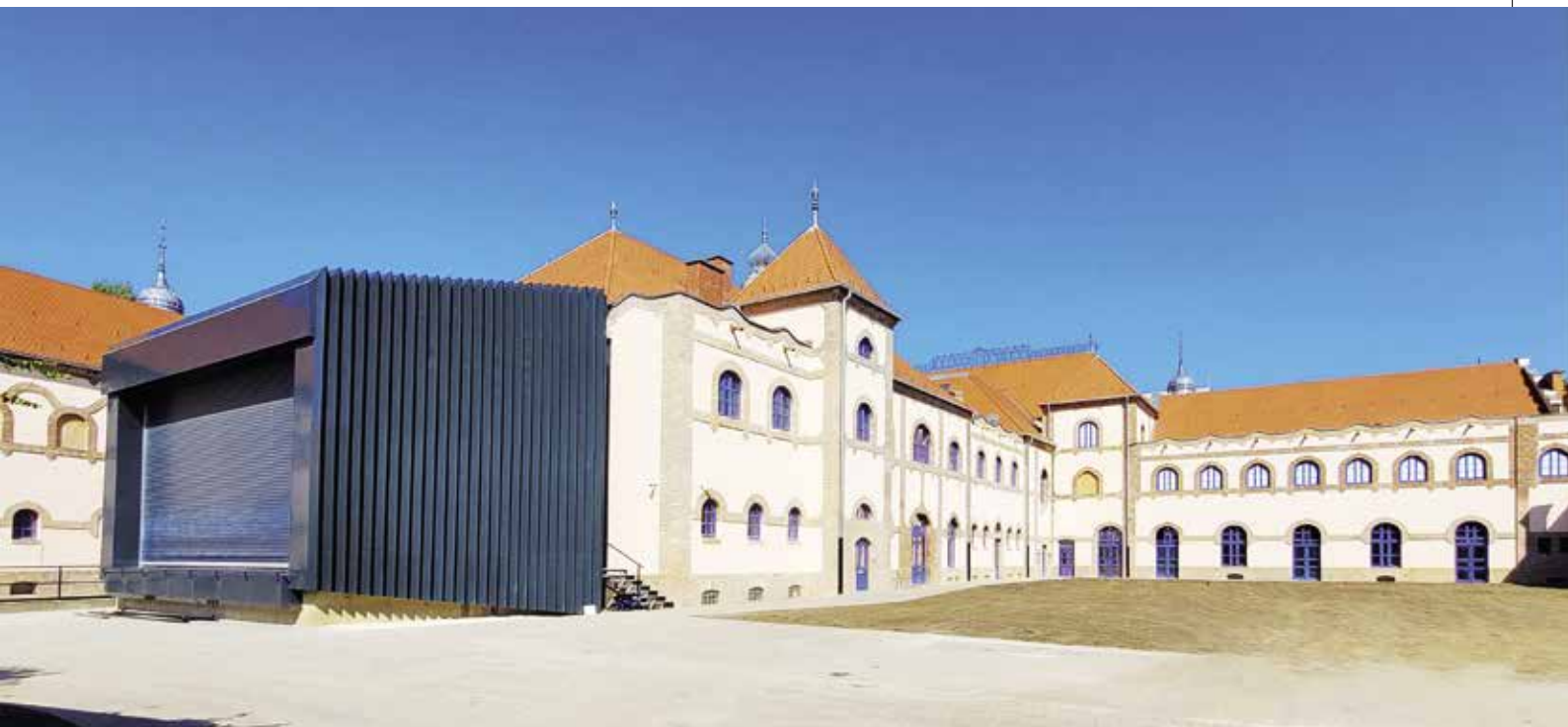
A felújított színházi szárny a színpadbővítéssel, a kinyitható hátfalal
