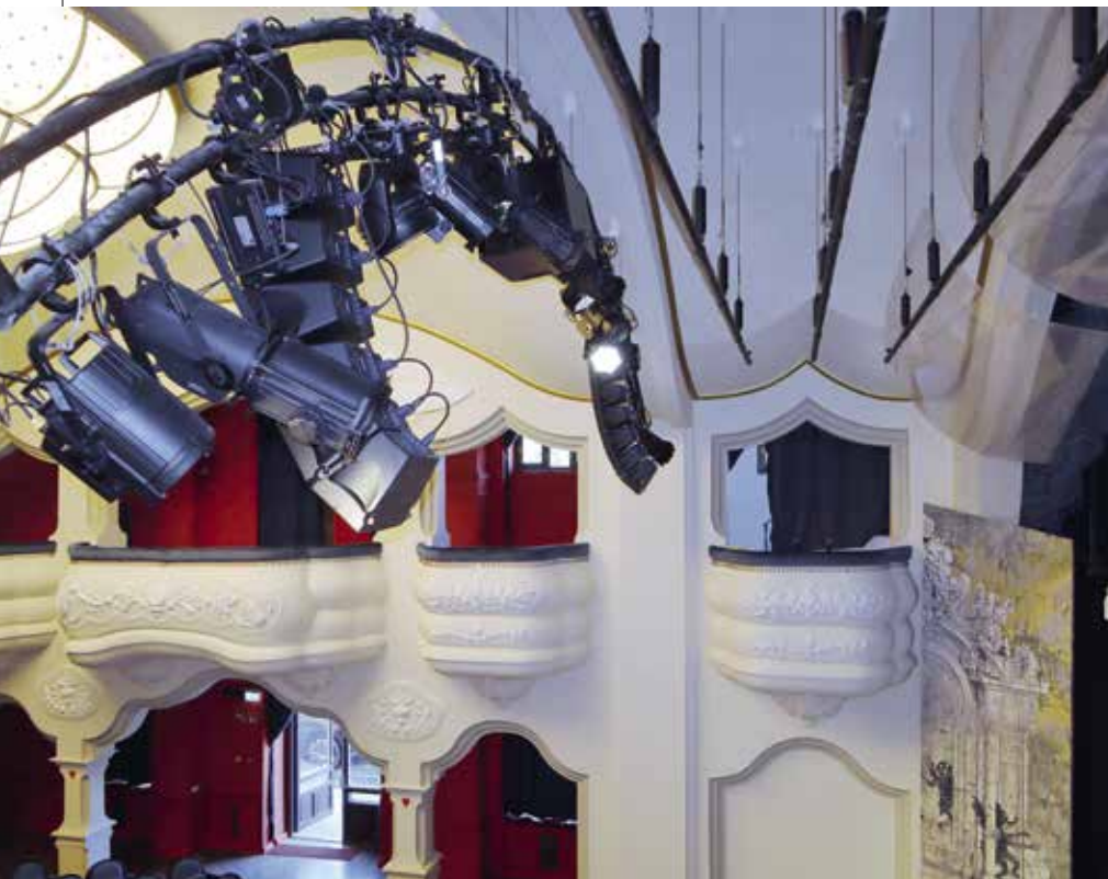
Nézőtéri világítási tartó hangfalakkal, az előszínpadi díszlethúzó mögött a hangvető plexilapokkal
