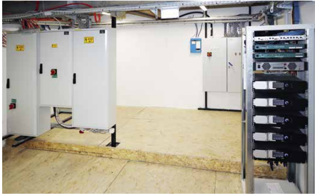
Erős- és gyengeáramú elosztóhelyiség
