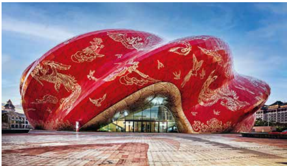
A Sunac Guangzhou Nagycirkusz tervezője a Steven Chilton Architects iroda
