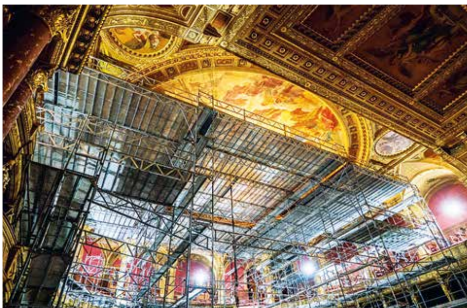
A nézőtér freskóinak felújítása
