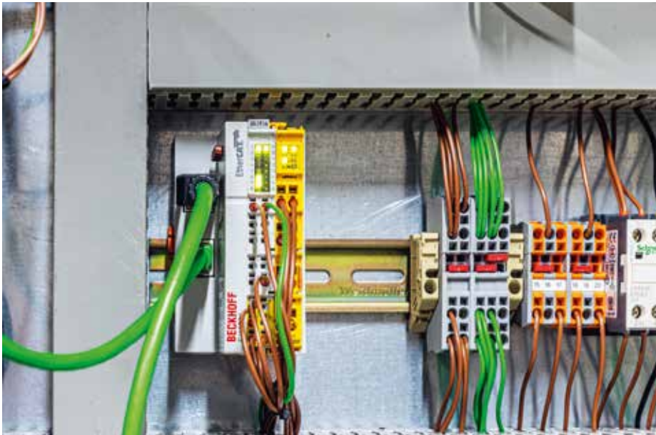
A hangsgárzó-mozgatás gépházában található EtherCAT-buszesatorló és az EL1904 biztonsági terminál
