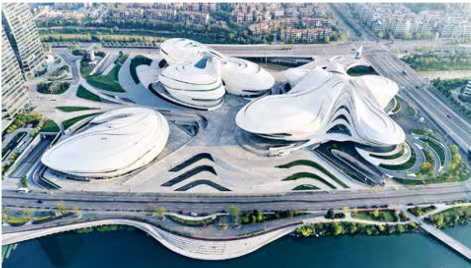
A jobb oldalon lévő épület a művészeti központ komplexum madártávlatból. Figyelemre méltó az úthálózat kialakítása
