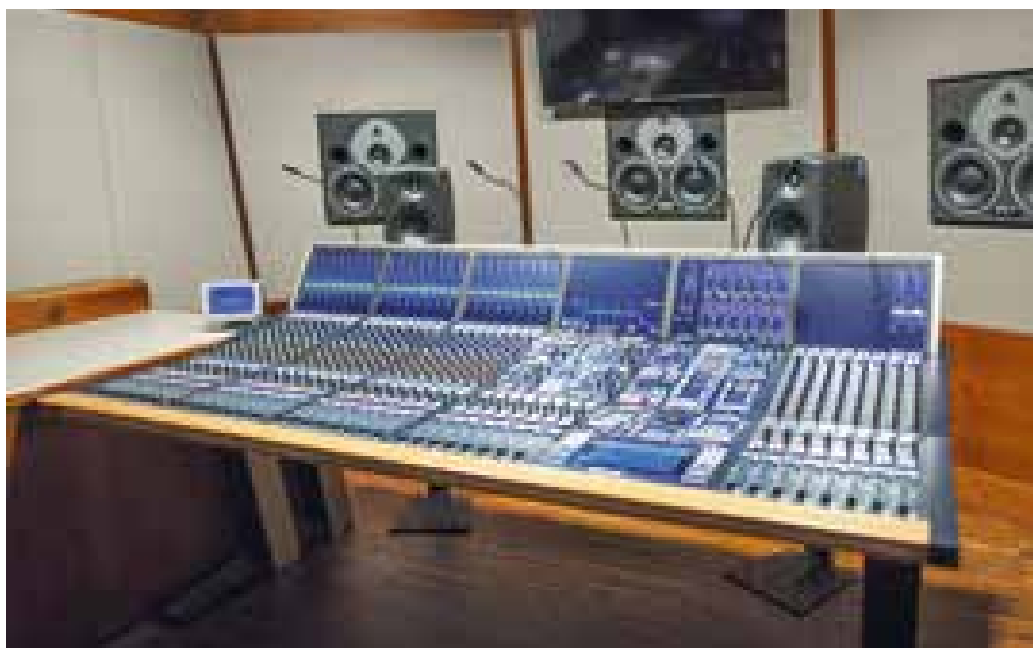
Hangstúdió II. (2. hangvezérlő, monitorozó)
