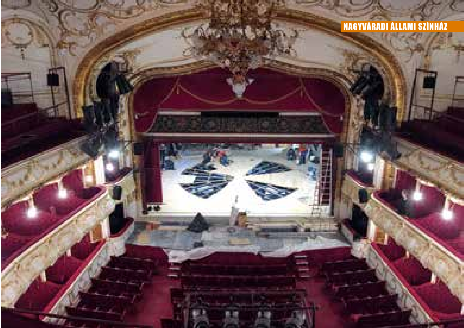
A forgószínpad padlózása a nézőtér felől nézve
