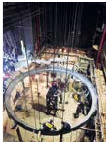
Forgószínpad beszerelése
