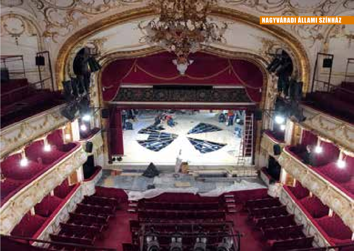
A forgószínpad padlózása a nézőtér felől nézve
