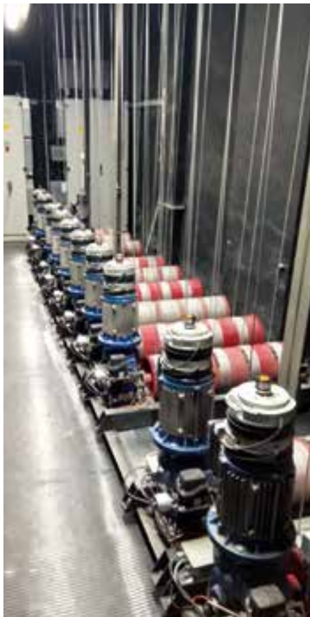
A felsőgépezet hajtássegységei
