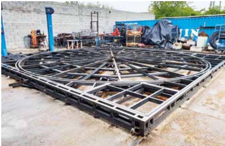
A kamaraszínház forgószínpadkocsijának gyártása
