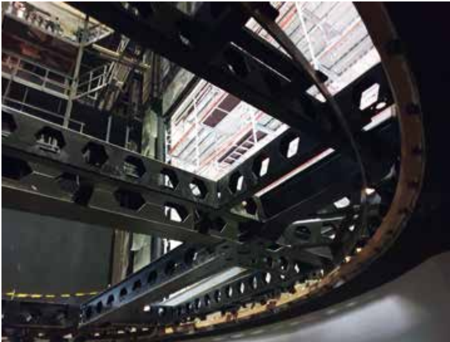
A dobforgó szerkezete alulról, beszerelés közben
