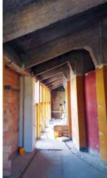
Az 1910-es vasbeton gerendák
