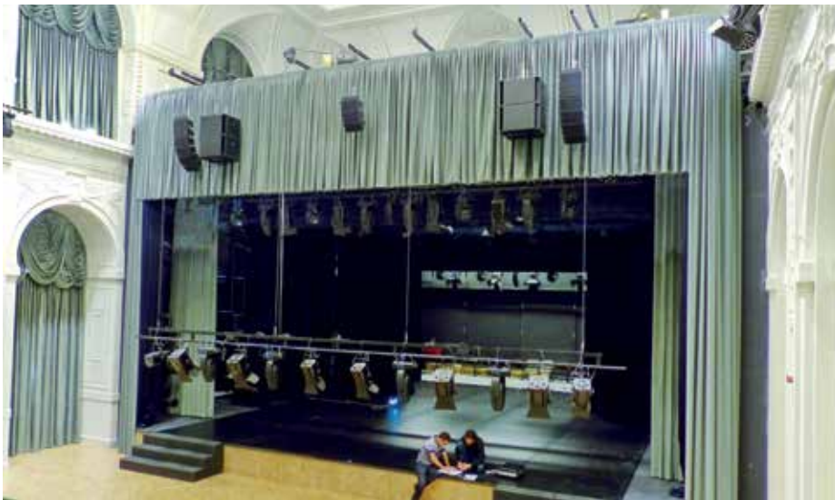
► Fronthangsugárzók a portál homlokl falán (a nézőtéri világítási tartó leeresztve)
