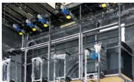
▶ A színpad munkakarzat szerelés közben
