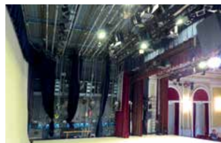
▶ A korábbi színpadgépezet kézicsörlőkkel
