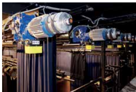
► Díszlethúzó hajtóművek a hátsó színpadon
