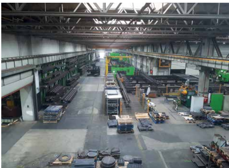
► Acélszerkezeteket gyártó és szerelő csarnok
