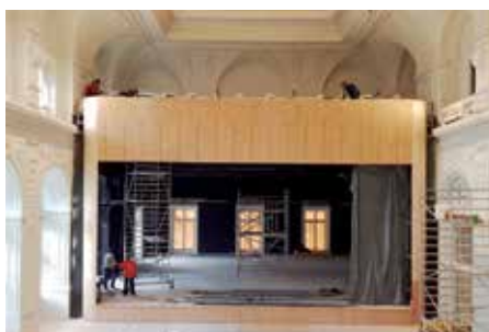
▶ Építik és szerelik a színpadot
