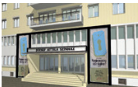
► A megújult bejárati homlokzat
