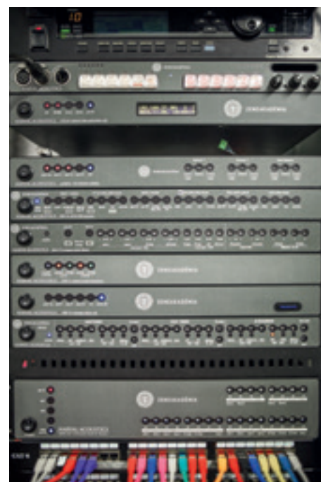
► Az intézmény magyar piaci szereplőkkel együttműködve új, széleskörű szolgáltatásokat biztosító, a színházi és a stúdiótechnikai üzemeltetést is kiszolgáló integrált ügyelői hang- és fényjelző, intercom rendszert is fejlesztett
