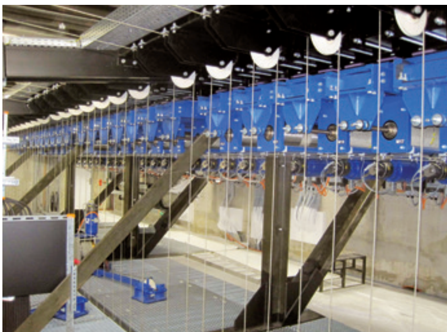
► Helytakarékos elrendezés: a díszlethúzó gépegységeit a zsinórpadlás oldalfalára szerelték
