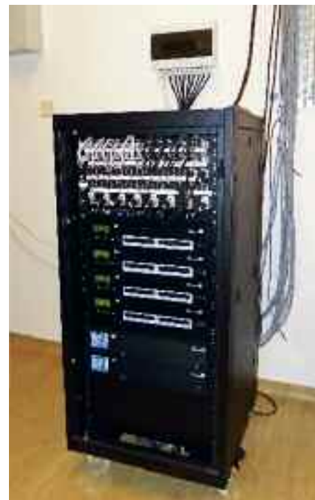
Végfokszekrény, melyben helyet kaptak a d&b audio-technik D80 és D6 erősítők
