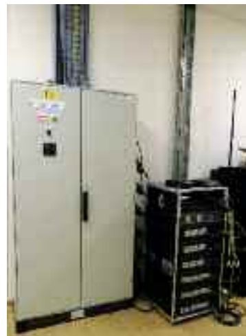
Erősáramú elosztó és a PLS dimmereket
