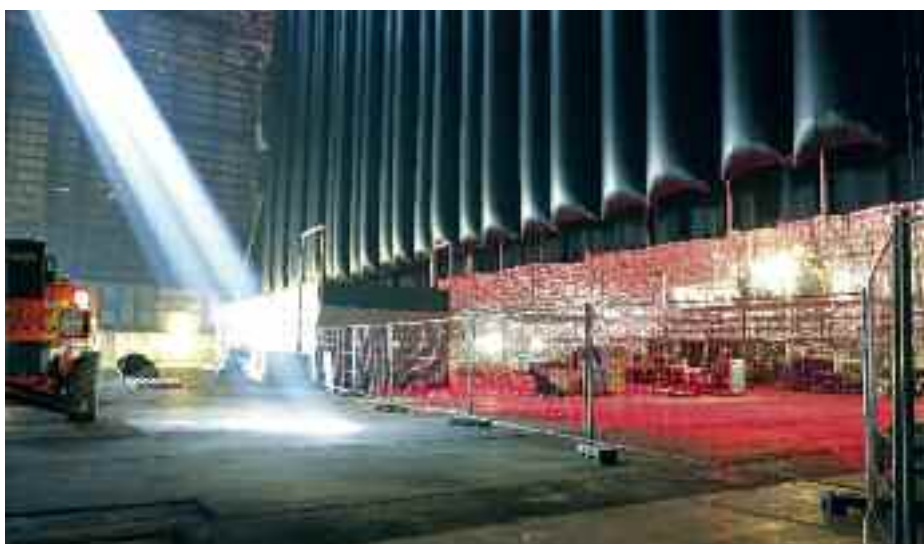
AqFlex® abszorberek az oldalfalra szerelve, Gerriets színpadi molton függönyökkel.
