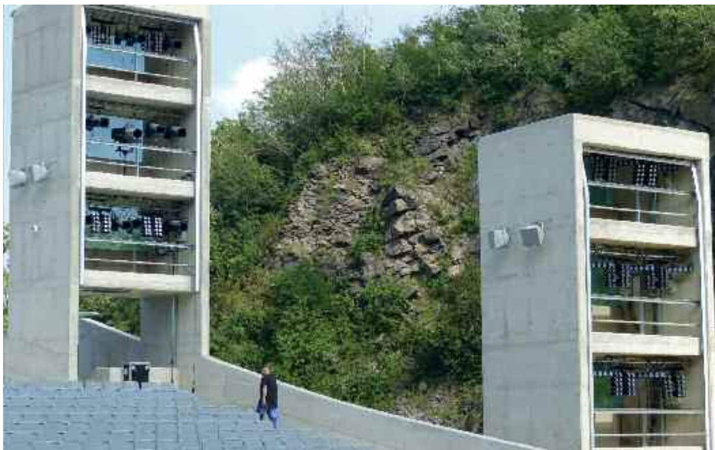
Világítási toronyok a nézőtér oldalán a LED fényvetőkkel
