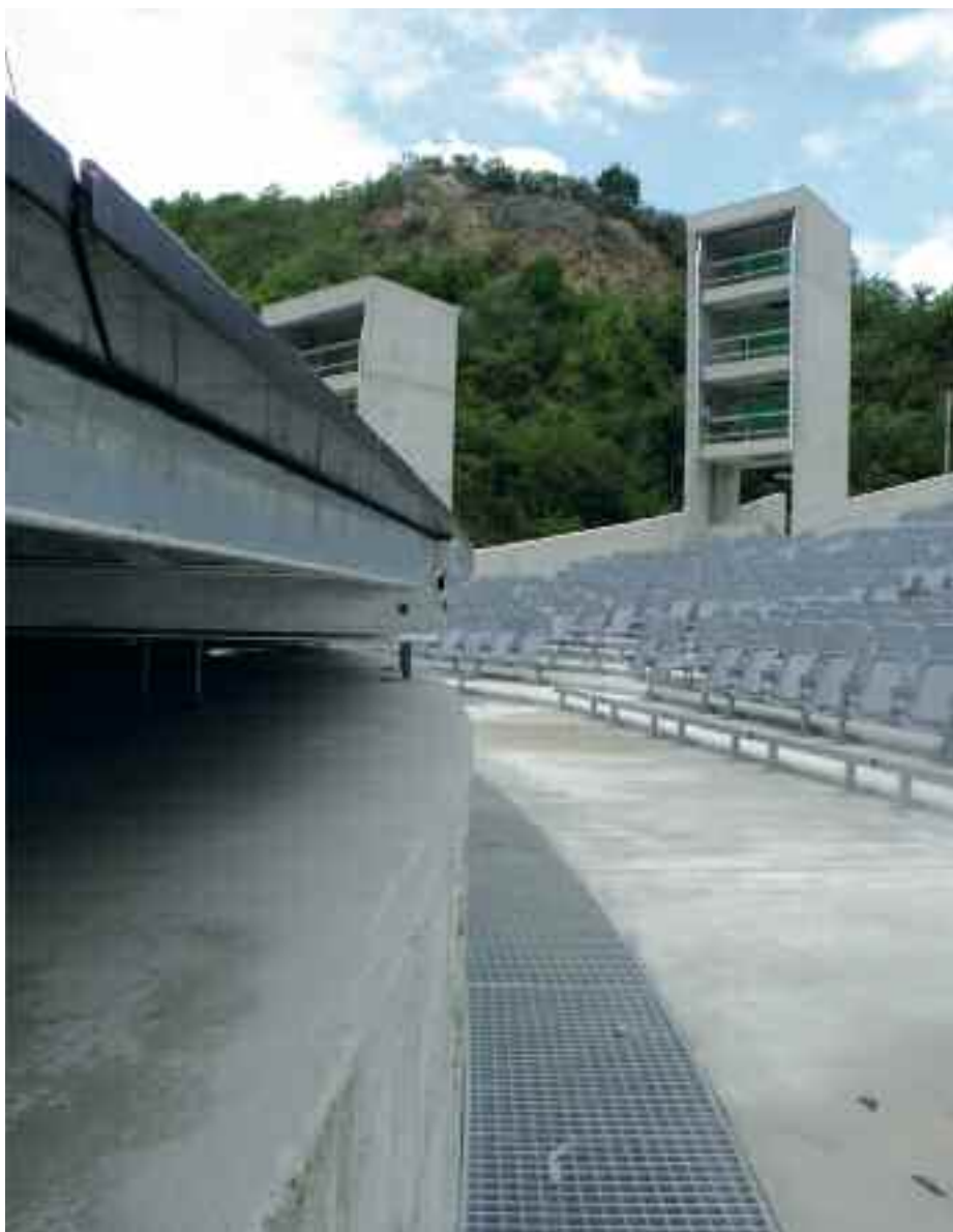
A színpadfödém vízvezető lejtősségét a vízszintes járőfelülettel kellett korrigálni
