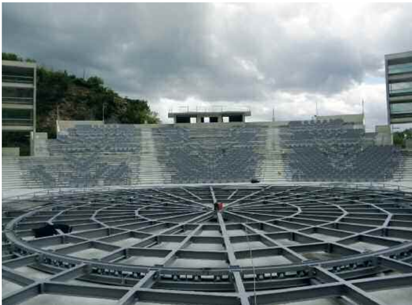
Forgószínpad szerelés közben
