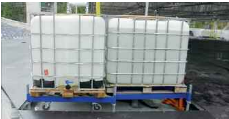
A vasbeton födémhez történő rögzítés helyett víztartályok biztosítják a szerkezet állékonyságát
