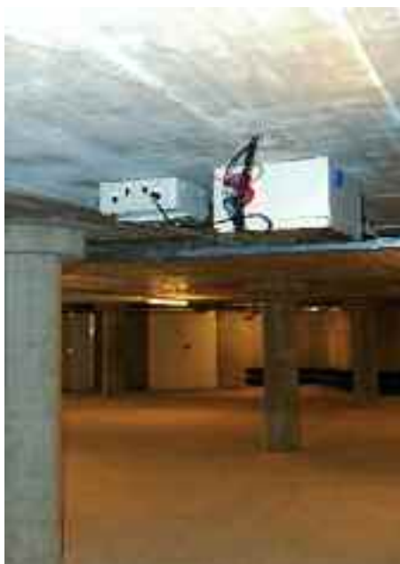
A színpad alatti elektromos- és DMX szekrények egyike
