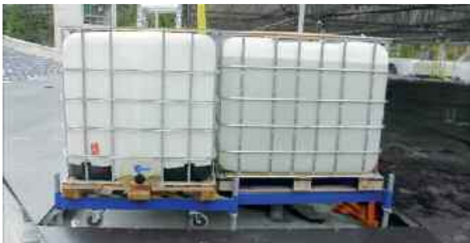
A vasbeton földémhez történő rögzítés helyett víztartályok biztosítják a szerkezet állékonyságát
