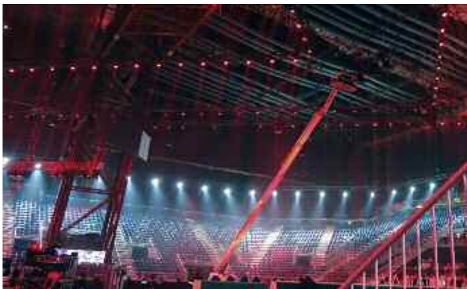
Az AqFlex® abszorberek felszerelése a mennyezetre a dalfesztivál helyszínén.
