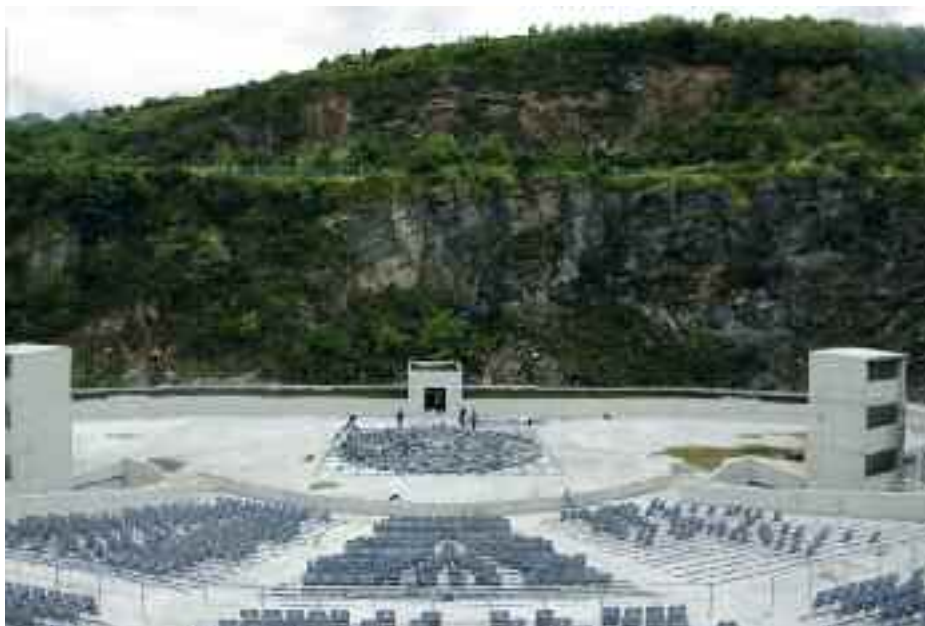
A színpad lejtajtős vasbeton felületén szerelik a forgószínpadot
