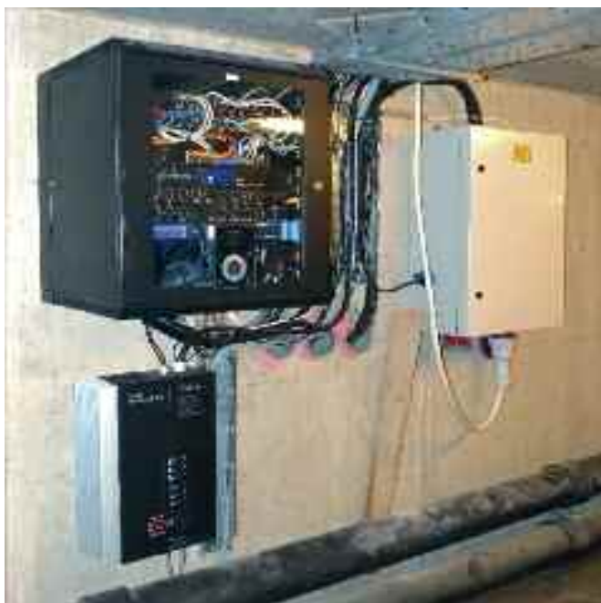
A színpad alatti elektromos- és DMX szekrények egyike
