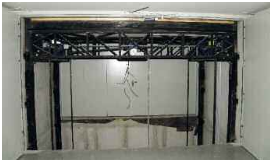
A kamaraterem díszletszállító emelője szerelés közben
