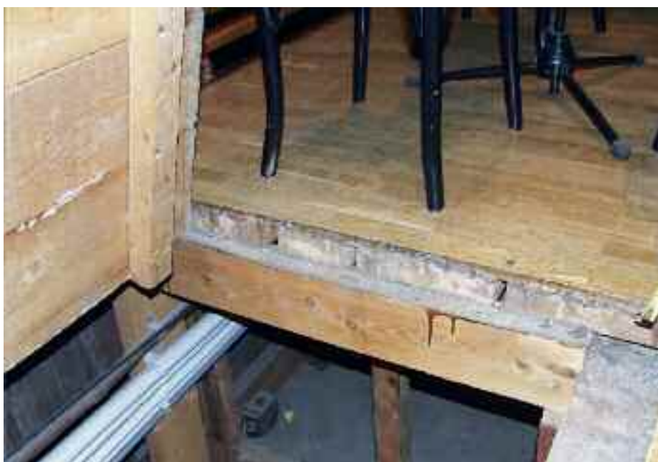
8.a és b ábra: A nagytermi pódium támasztógerendázatának (a) és padlójának (b) eredeti szerkezete
