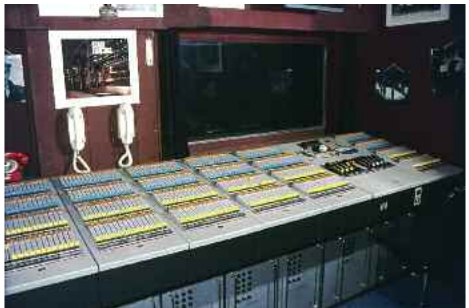
16. ábra. FB 180/A áramkörös modul felépítésű, elektronikus vezérlőasztal (Vígsház, 1976)
