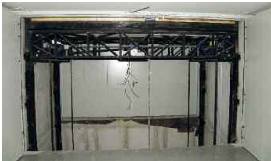
A kamaraterem díszletszállító emelője szerelés közben
