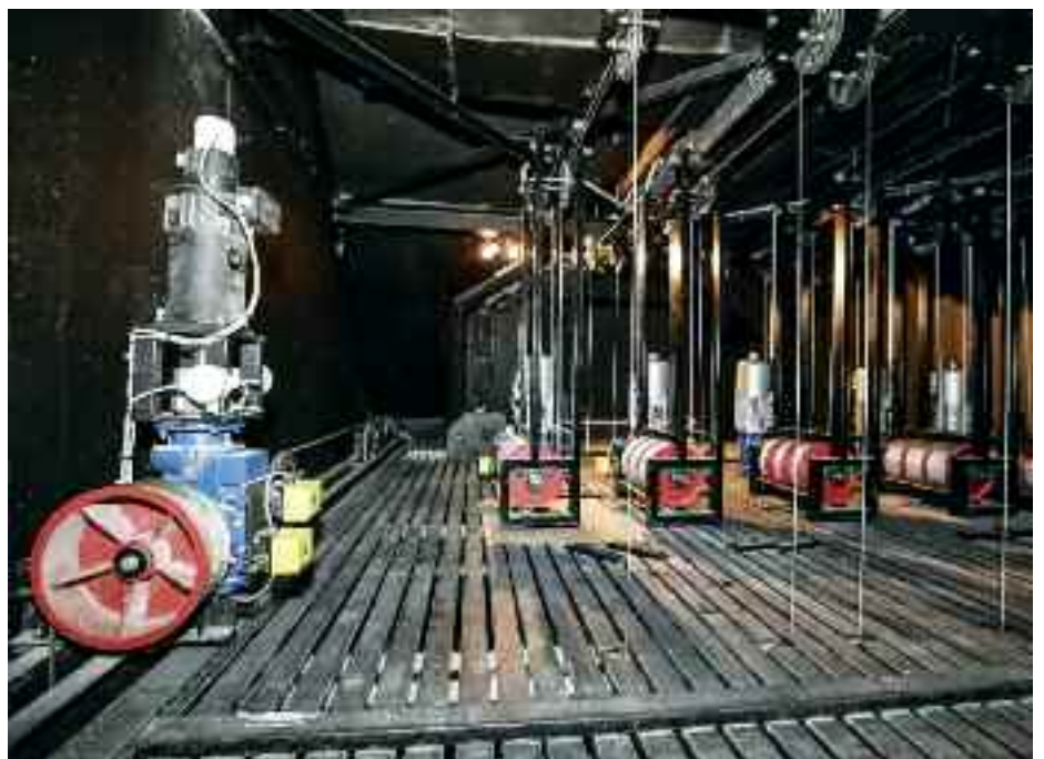
A kamaraterem felsőgépezete. Elöl a biztonsági függöny, hátrébb a díszlethúzó hajtásegységei a zsinórpadláson
