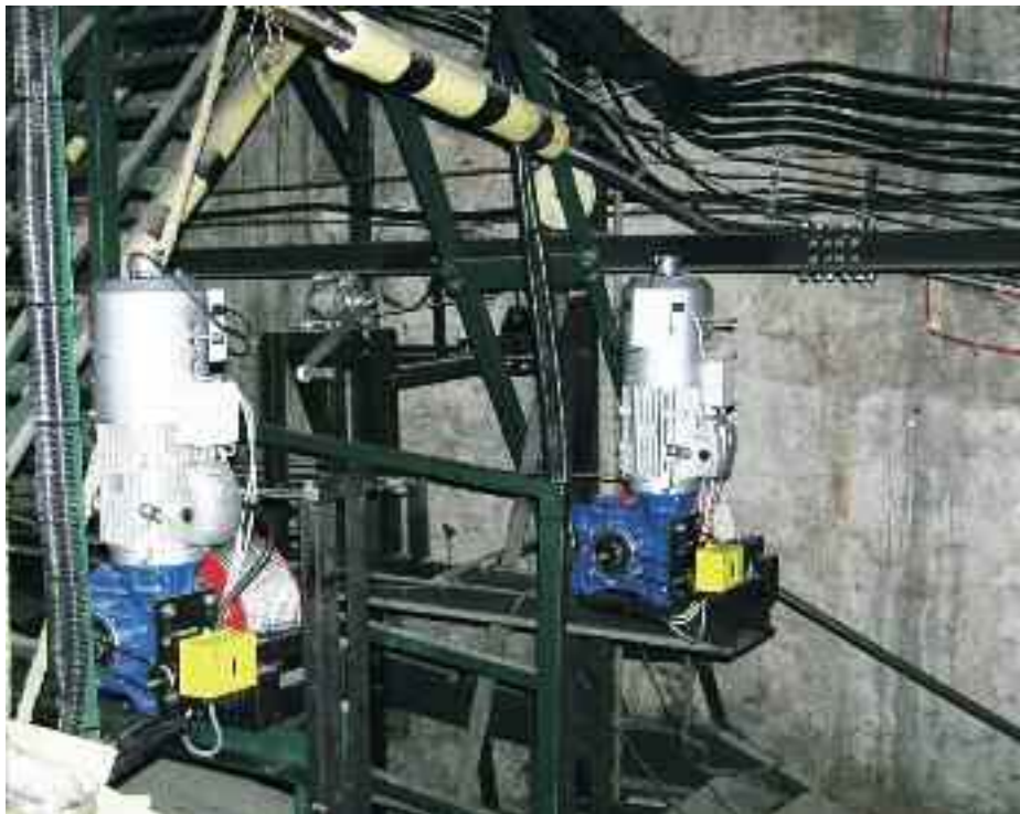
Előszínpadi gépi húzók a padlástérben
