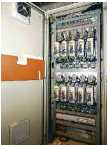
A szinkron díszlethúzóknak vezérlése
