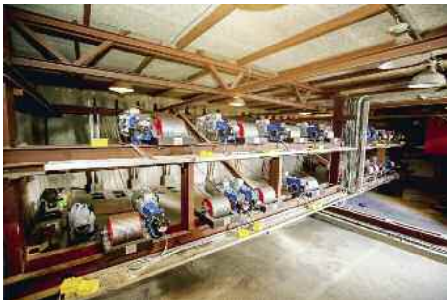
Gépi díszlethúzóknak hajtásegységei
