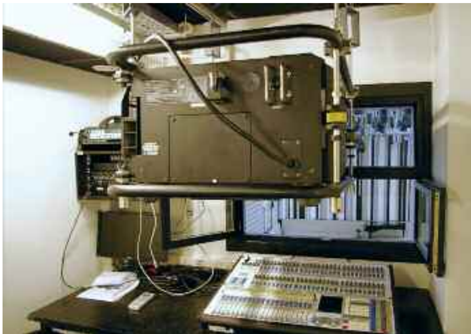
Fényvezérlő – a projektor sínen elcsúsztatható
