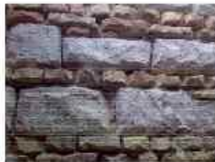
helyszínen készített, tisztított mintafelület
