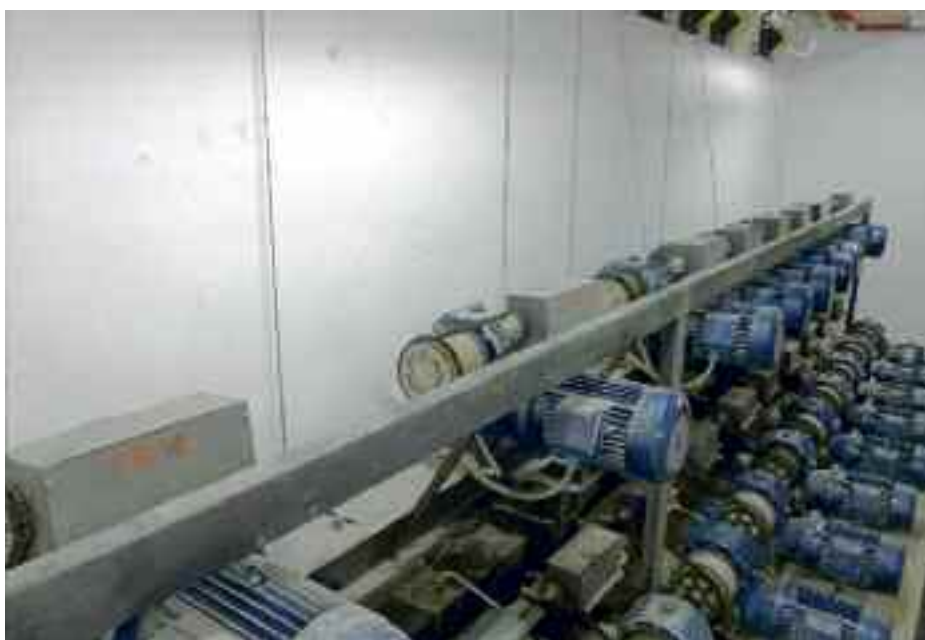
20 db gépi díszlethúzó hajtóművei a pincében, ebből 7 üzemképes
